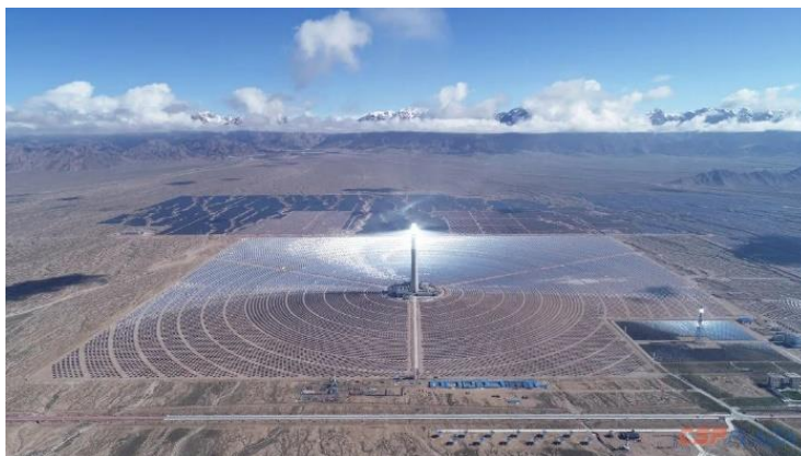
图 1 德令哈 10MW 塔式光热电站
