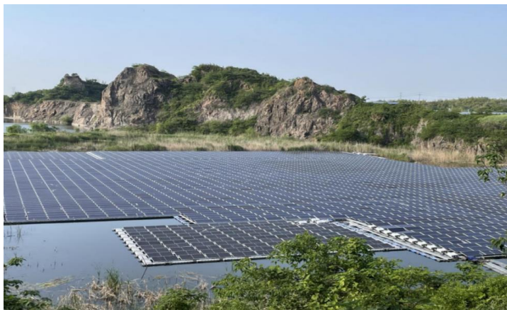
图 3 海盐光伏项目
